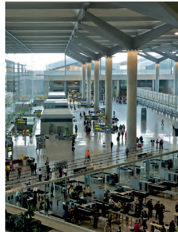
El Aeropuerto de Málaga-Costa del Sol ha reformado el alumbrado del interior de los edificios.
