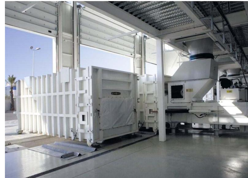
Sistema neumático de recogida de residuos.
