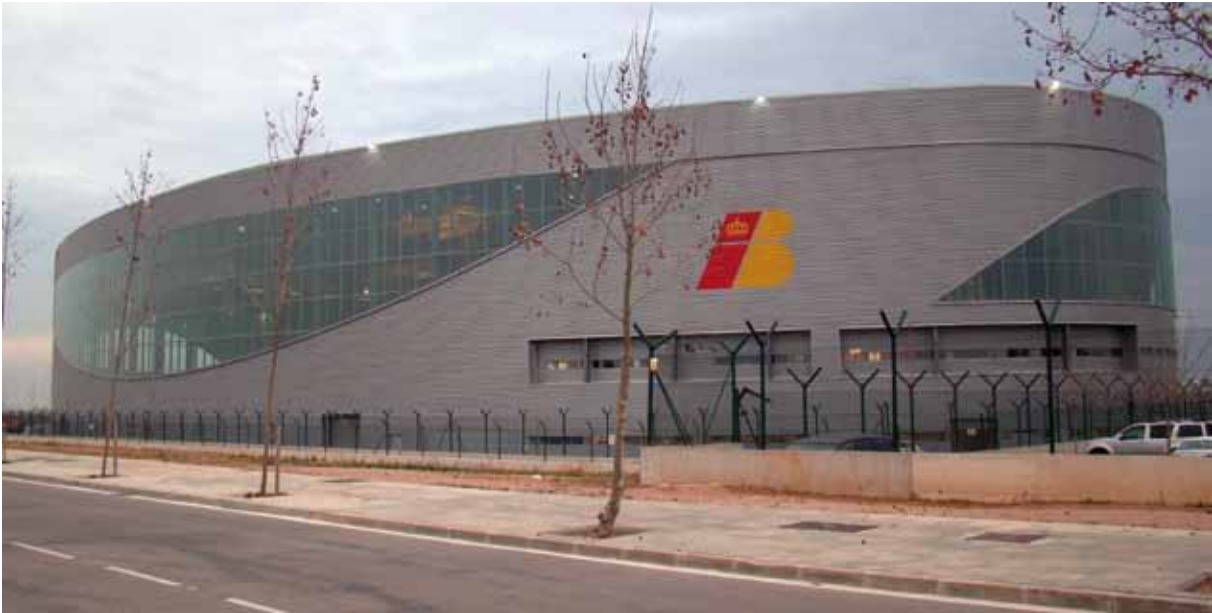
En octubre de 2010 se inauguró en el Aeropuerto de Barcelona-El Prat el hangar de mantenimiento de Iberia
