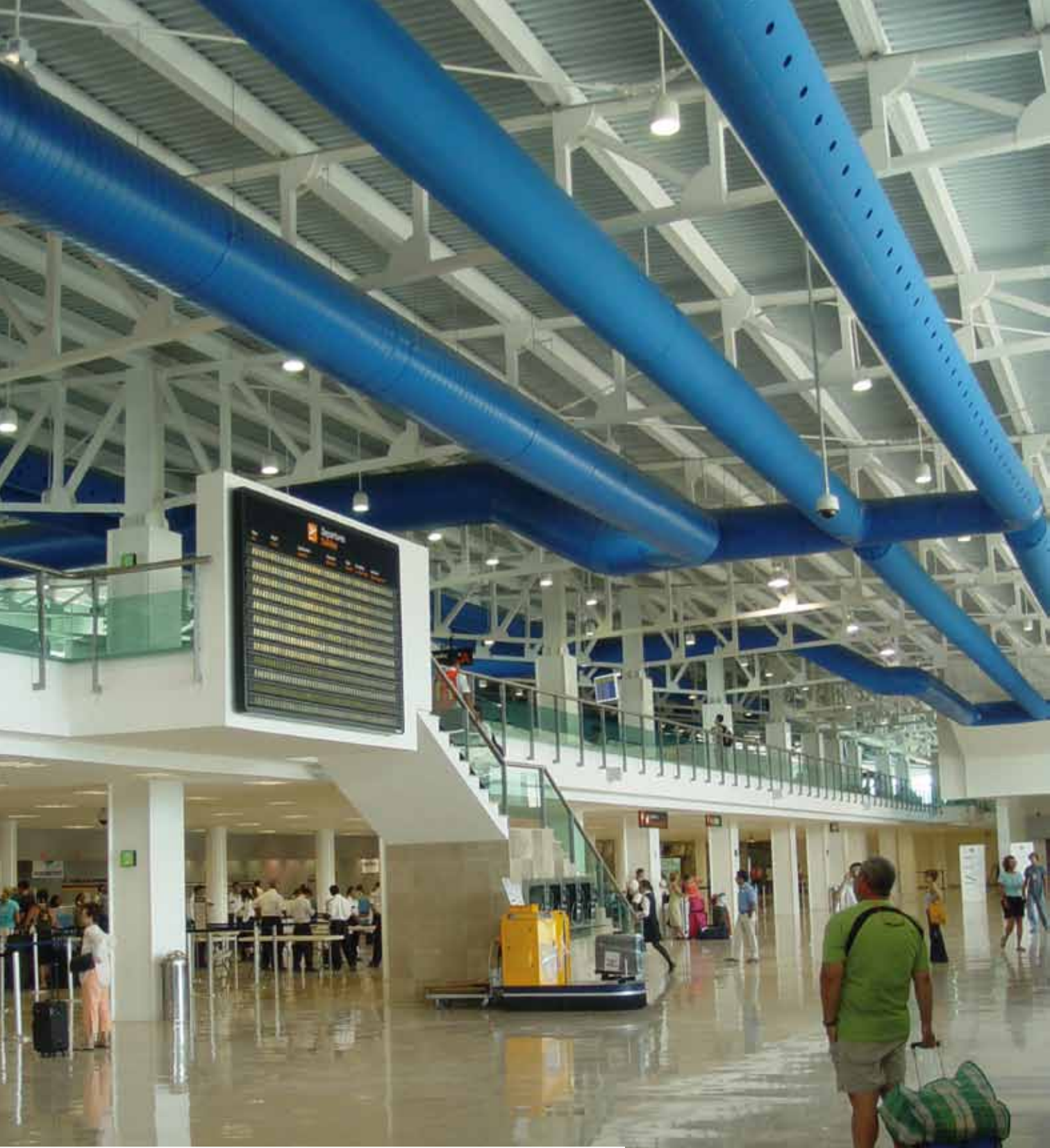
Terminal del Aeropuerto de Puerto Vallarta (México)
