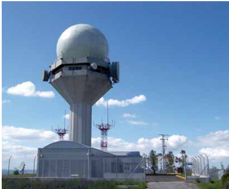
Radar de Espiñeiras en A Coruña
