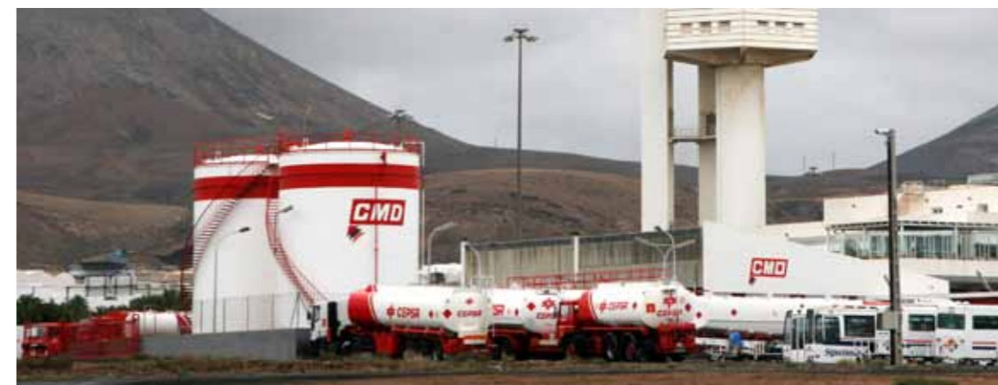
Las instalaciones de combustible son objeto de control y seguimiento
