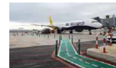
Imagen 17. Adecuación senda peatonal. Aeropuerto Alicante-Elche
