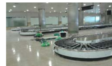
Imagen 23. Cintas del nuevo patio de carrillos. Aeropuerto de Gran Canaria
