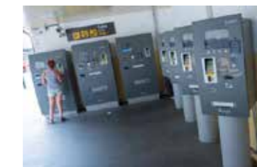
Imagen 29. Cajeros de pago de aparcamientos. Aeropuerto de Girona-Costa Brava
