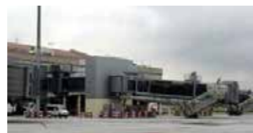
Imagen 21. Nuevas pasarelas. Aeropuerto de Málaga-Costa del Sol
