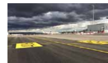
Imagen 16. Reparación pavimento calles de rodaje. Aeropuerto A.S. Madrid-Barajas
