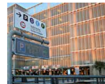
Imagen 28. Aparcamiento. Aeropuerto de Barcelona-El Prat
