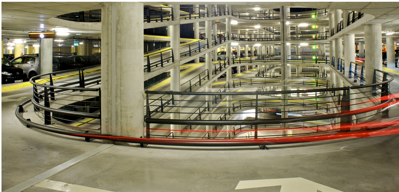
Aparcamiento del Aeropuerto de Barcelona-El Prat
