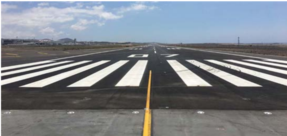
Pista repavimentada Aeropuerto Tenerife Sur
