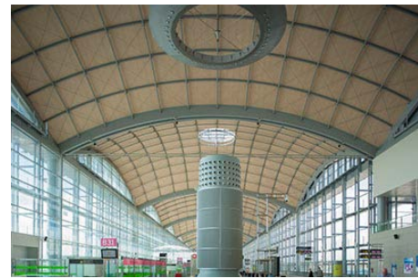
Terminal del aeropuerto de Alicante-Elche
