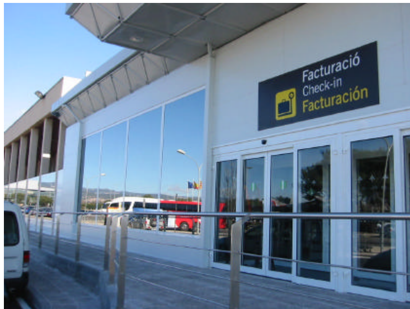
Edificio de facturación junto a la terminal ya existente
