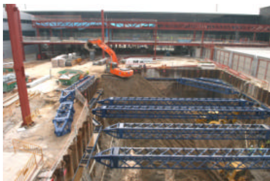
Detalle de la excavación de la planta sótano
