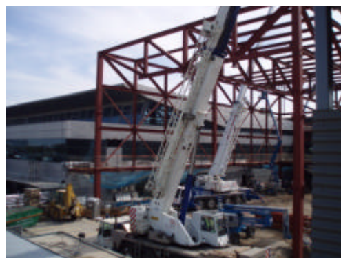
Construcción de la estructura metálica
