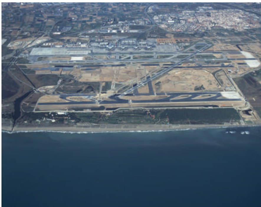
Vista aérea de la Tercera Pista en enero de 2004, una vez han concluido los trabajos de asfaltado de la pista
