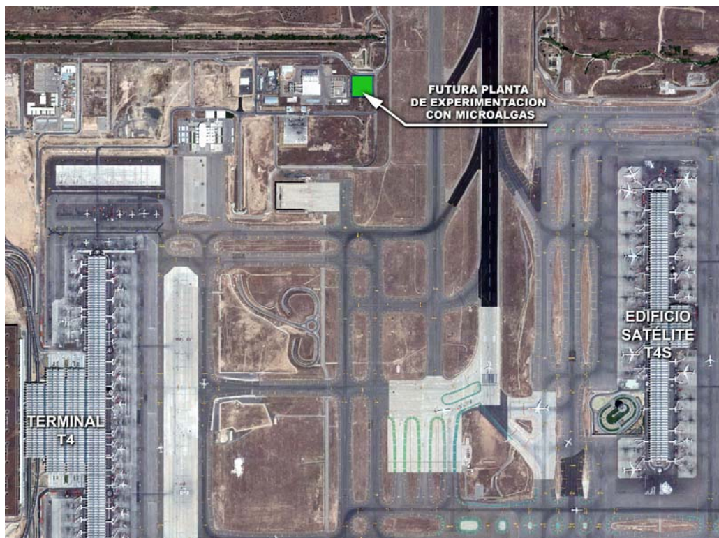
Ubicación de la planta de experimentación con microalgas en el aeropuerto de Madrid-Barajas
