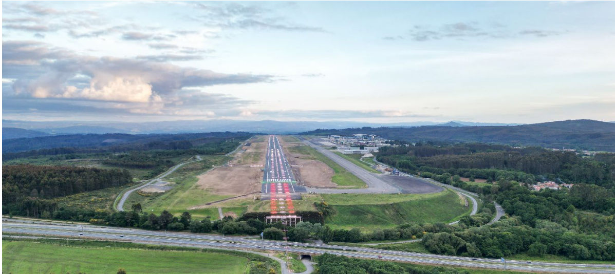
Pista del Aeropuerto de Santiago-Rosalía de Castro durante las obras de regeneración del pavimento. © Aena
