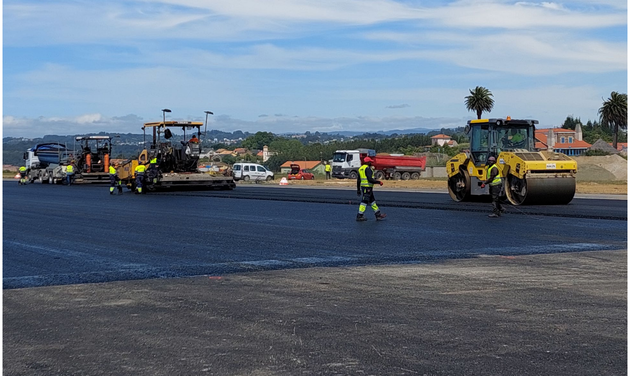
Máquinas trabajando en las últimas capas de asfalto.
