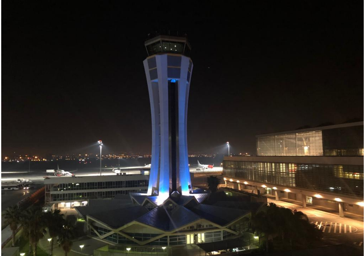
Torre de control del Aeropuerto iluminada de azul.
