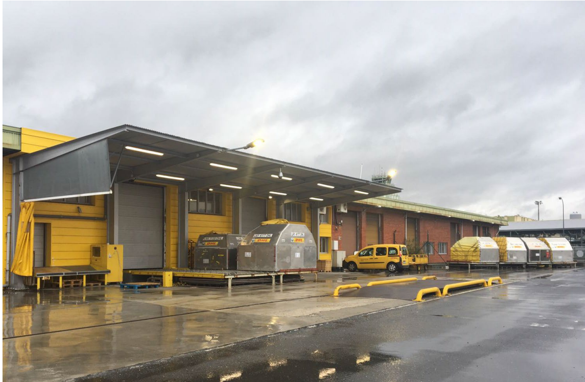
Instalaciones de la terminal de carga aérea del Aeropuerto de Santiago-Rosalía de Castro
